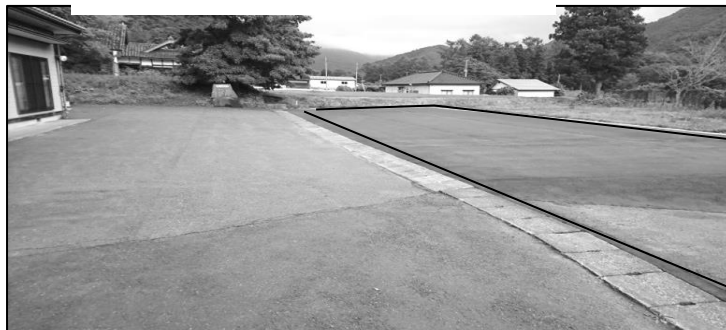
線で囲まれた部分が今回舗装工事した部分 240㎡
